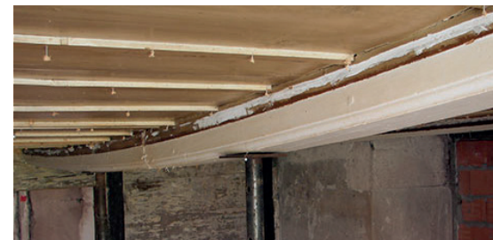
Neben dem Luftschall- und Brandschutz verbessert das Elascon HBV-System auch die Biege- und Schwingungssteifigkeit deutlich.
